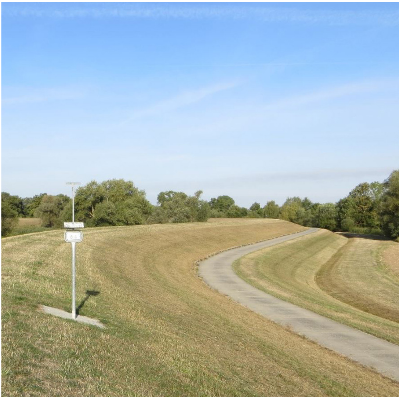
Abbildung 4: Elbedeich im Amt Neuhaus mit Kennzeichnung der Deichkilometer und Deichverteidigungsweg
