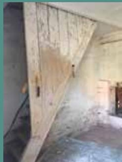
Zwischenwände werden zurückgebaut, so dass ein Raum mit einer Gesamtfläche von 25 m<sup>2</sup> entsteht. Der Treppenlauf (Bild unten rechts) bleibt erhalten.
