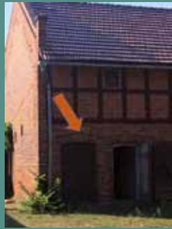
Die Türen bleiben erhalten und werden tischler- und malermäßig überarbeitet. Der Eingang wird barrierefrei angepasst. Die linke Tür wird „Schaufenster“, die rechte Tür (blauer Pfeil) wird Eingang.
