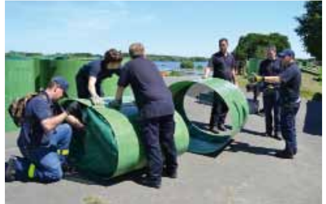
Aufbau des mobilen Schutzdamms in Gartow
