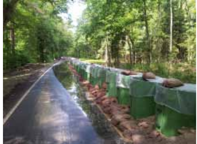
mobiler Schutzwall in Gartow
