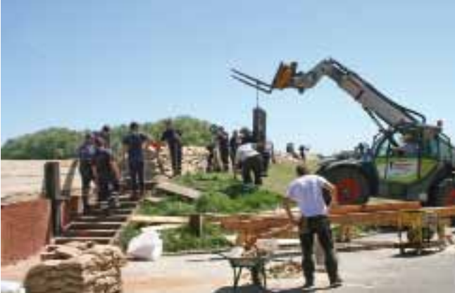
Deichbauarbeiten in Wussegehl
